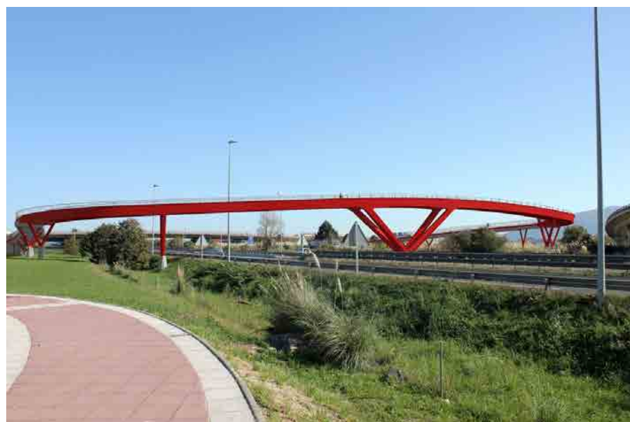
En la imagen, un ejemplo de pasarela como la que se podría instalar para superar la A-4.
