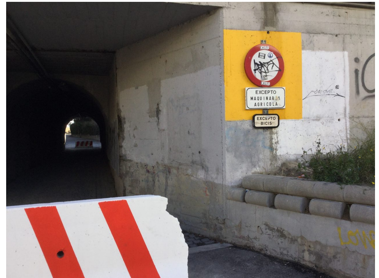
Vista del estado actual del Túnel de San Antón, visto desde el lado del casco urbano de Pinto.
