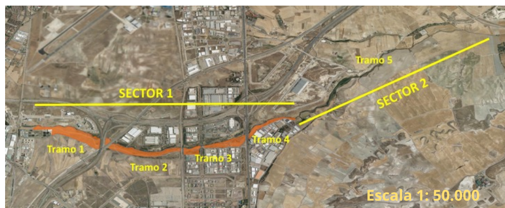
Sectorización para abordar los trabajos de renaturalización del arroyo Culebro.
