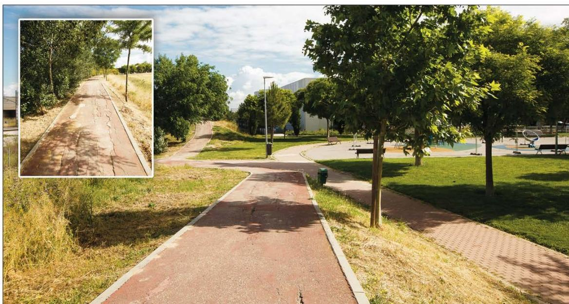
Reforma de la actual senda existente en la coronación del talud paralelo a la vía de Ferrocarril en la Tenería I por encontrarse en muy mal estado como consecuencia de la falta de resistencia del firme y del terreno.
