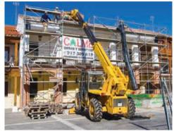
madera también se cambiará por otra metálica, habrá un refuerzo con chapa del forjado de bajo cubierta y se contará con un nuevo sistema de evacuación de las aguas pluviales con nuevos canalones y bajantes. Las obras, que concluirán antes de fin de año y tienen un presupuesto de cerca de 50.000 euros, respetarán la imagen clásica del edificio, puesto que tras su finalización se volverá a tejar y tendrá su aspecto habitual.
